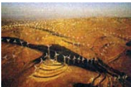
Figura III.39. En México se encuentra el parque eólico de La Venta, Oaxaca.
