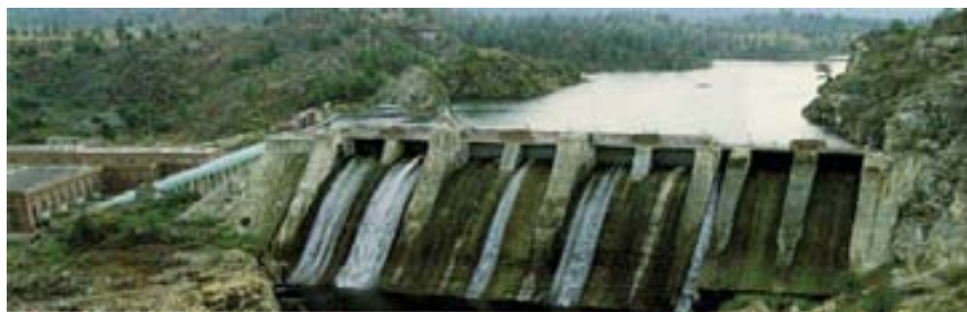
Figura III.41. En México contamos con centrales hidroeléctricas, como la de Chicoasén. Cuenta con cinco generadores de 300 mW cada uno. Se halla a 21 km al norte de Tuxtla Gutiérrez, a la salida del Cañón del Sumidero, en Chiapas.
