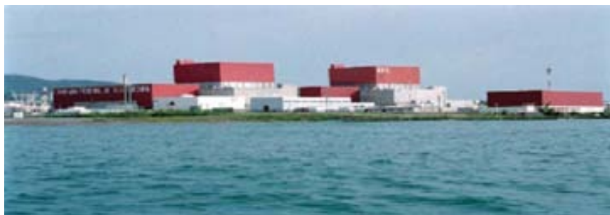
Figura III.44. La Central Nuclear de Laguna Verde se encuentra en un proceso de modernización de sus instalaciones con lo que se pretende ampliar su vida útil al menos 20 años más.
